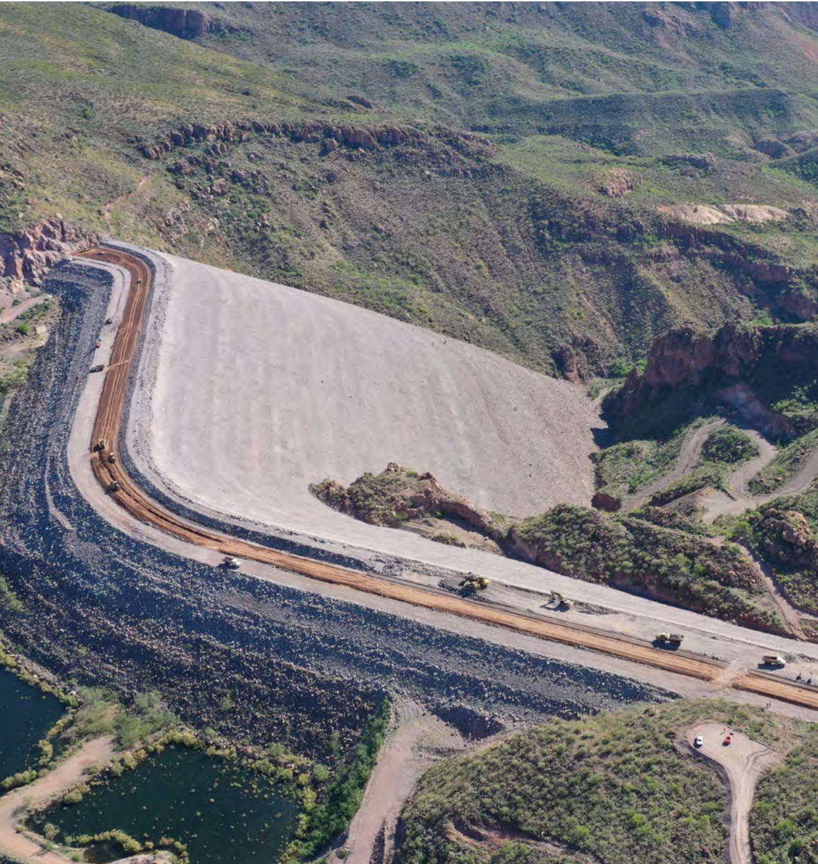
📷 Tailings dam in La Caridad, Sonora, Mexico.
